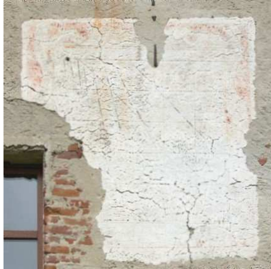
cadran 2, avant la restauration (03-2007)
