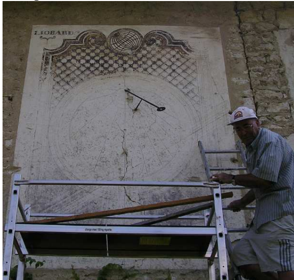
Cadran "Liobard" à Gouvoux Saint-Victor-de-Morestel (38), avant restauration.
